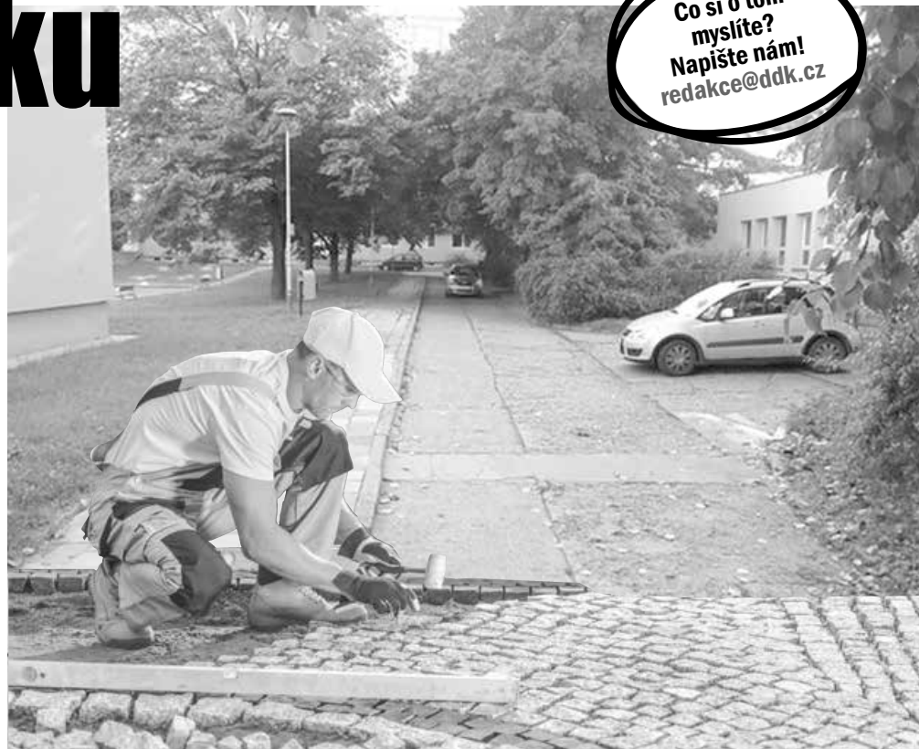
■ Ulice 1. máje a 28. října čeká především oprava komunikací a nevyhovujících chodníků. FOTO: MESTO-UH A KOLÁŽ DOBRÉHO DNE
