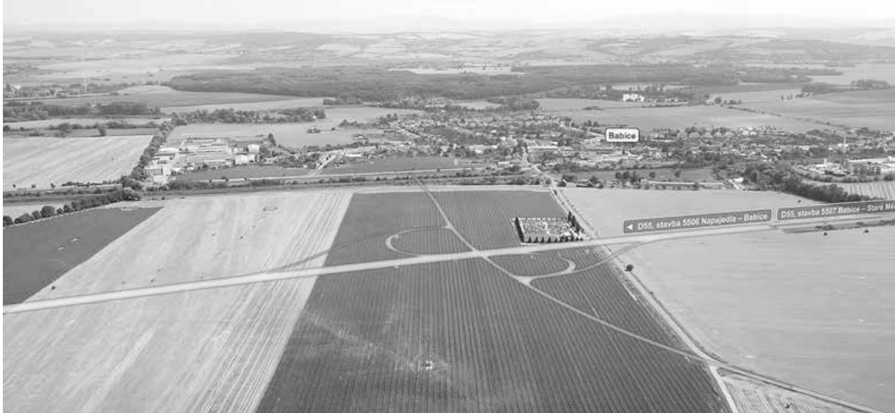
■ Stavba osmikilometrového úseku z Babic do Starého Města přijde odhadem na tři miliardy korun, odvede velkou část tranzitní dopravy z Babic, Huštěnovic a Starého Města. FOTO: RSD
